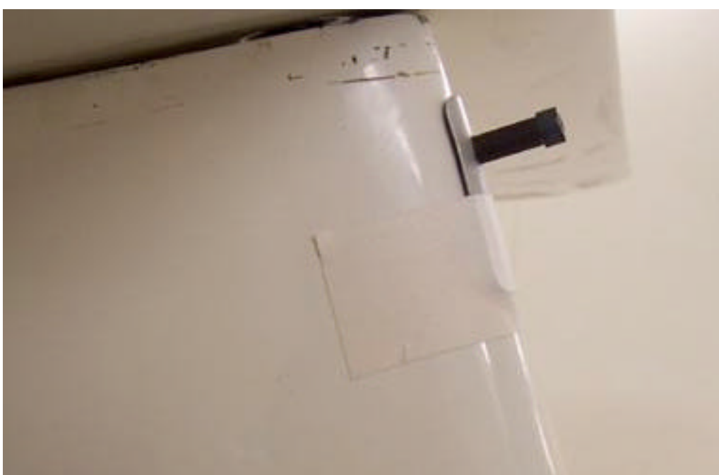
Fig. 2 Låsmekanism med vävtejp
